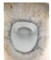
水が溜まる部分の輪じみ
